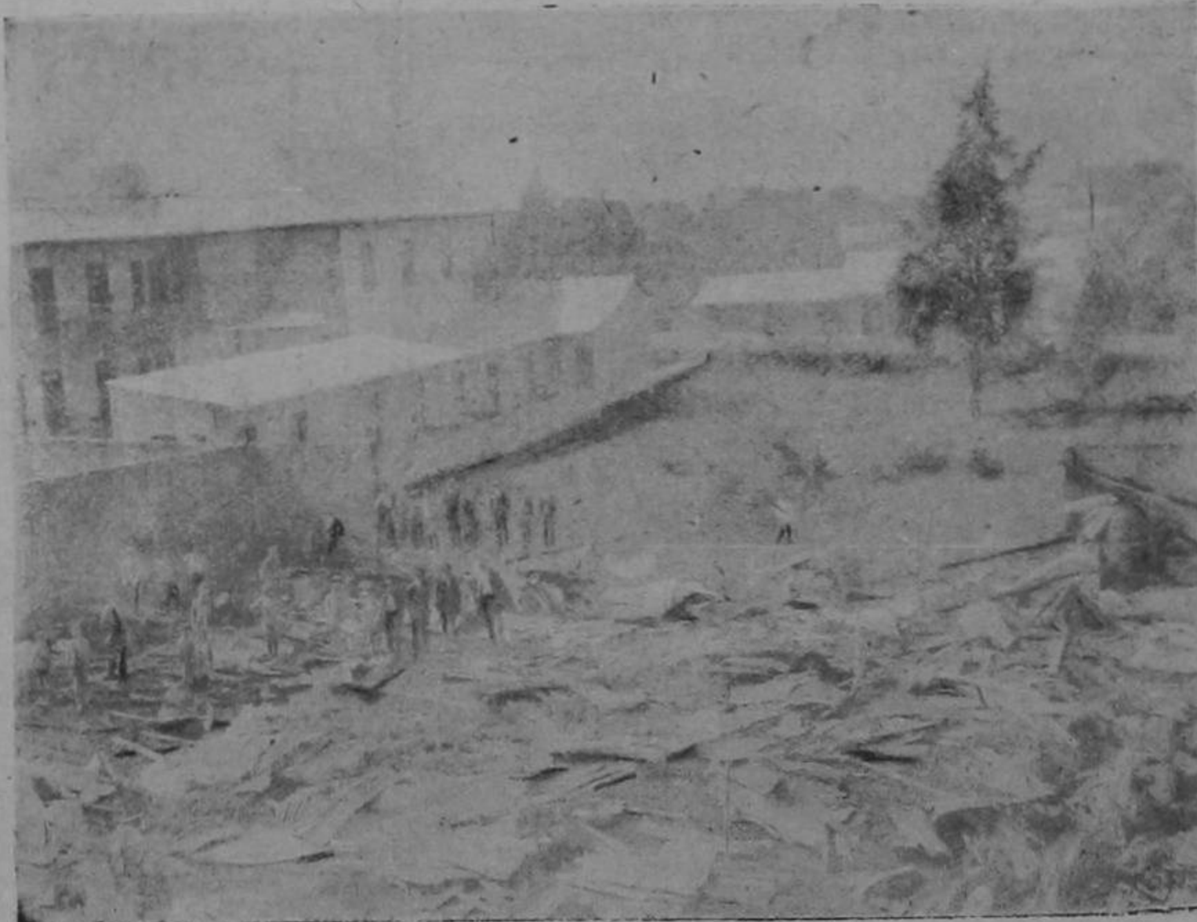
Aspecto que presentan los edificios quemados
